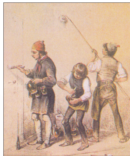
Obige Zeichnung ist um das Jahr 1840 entstanden. Die Tür wird mit einem Kluppenpinsel gestrichen. Die Rundbürste (Quast) mit Stiel zum Kalken mit Verlängerungsstiel ist mit einem großen Knollenpinsel vergleichbar. Der Lehrling reibt im Mörser Trockenfarbe an.
